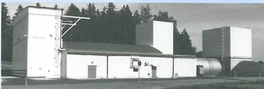
F7:s nyrenoverade Motorkörningshus med de tre luftintagstornen som markanta nyheter
